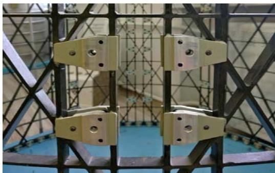
Рис. 3.26. Металлические накладки
